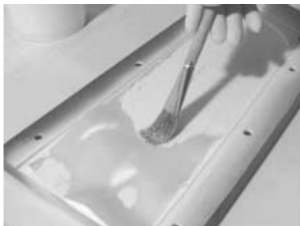
Bild 4 - Die vorher zugeschnittene(n) Faserverstärkungslage(n) (z.B. Glasfilamentgewebe 48 g/m 2 ) wird (werden) vollflächig und luftblasenfrei mit Epoxid-Laminierharz-System EPL 285/EPH 285 am gehärteten Polyester-Vorgelat Typ 740 weiß anlamiert.
